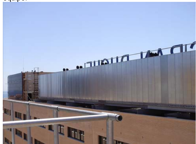
Figura 04. Detalle de la instalación de pantalla
