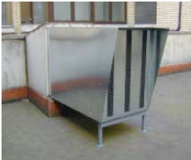
Figura CAL-06. Ejemplo de un silenciador
