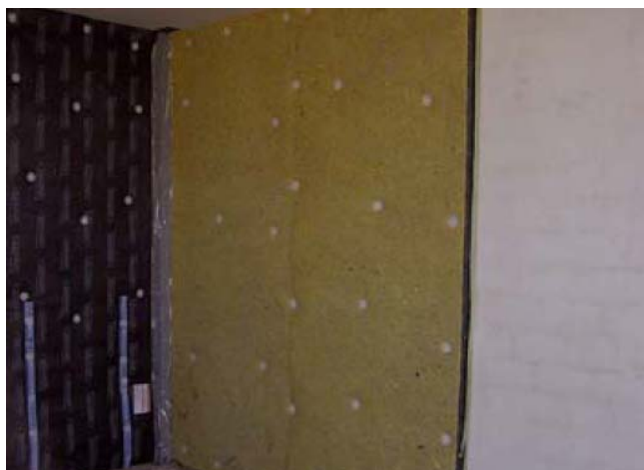
Figura R_INST-05. Ejemplo de un trasdosado
