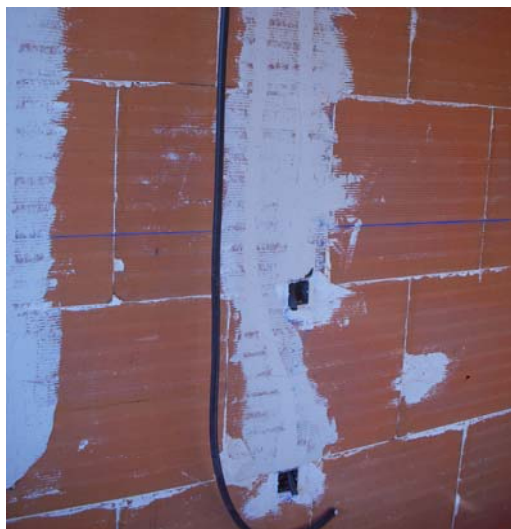
Figura CH-1. Detalle rozas retacadas
