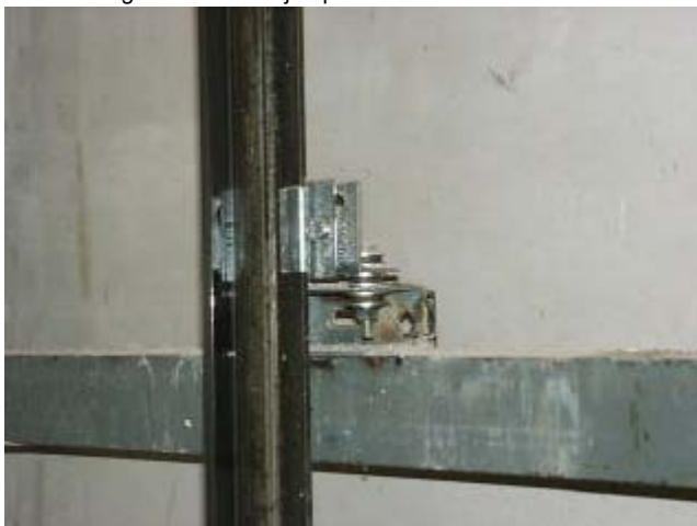
Figura ASC-04. ejemplo de anclaje de guías
