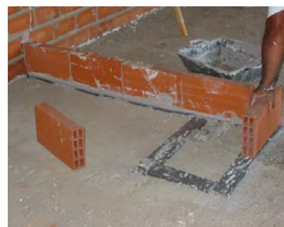
Detalle del replanteo y ejecución de particiones con bandas elásticas
