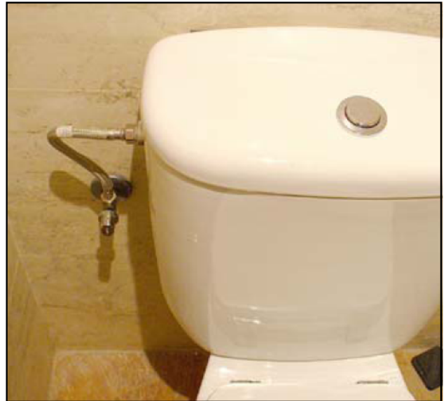
Figura CH-5. Conectores flexibles y junta elástica desolidarizadora
