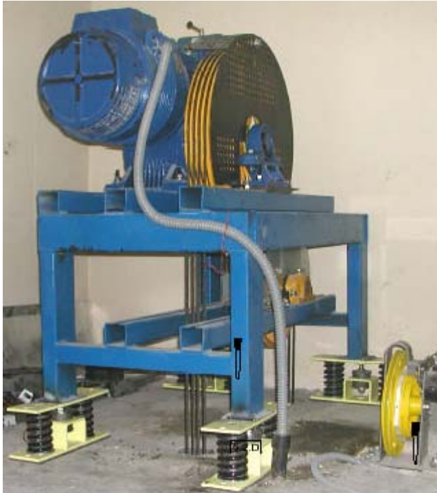
Figura ASC-02. Ejemplo maquinaria de ascensor con soportes antivibratorios.
