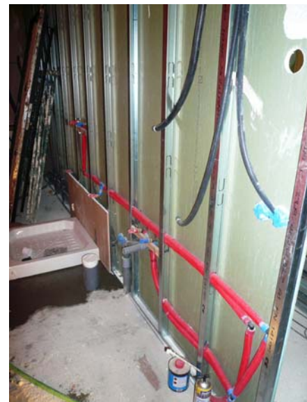
Detalle ESV-03.b.R3. Instalación correcta de las tuberías entre los perfiles de las placas de yeso laminado
