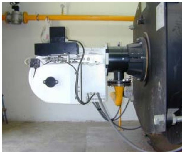
Figura CAL-02. Ejemplo quemador sin encapsular
