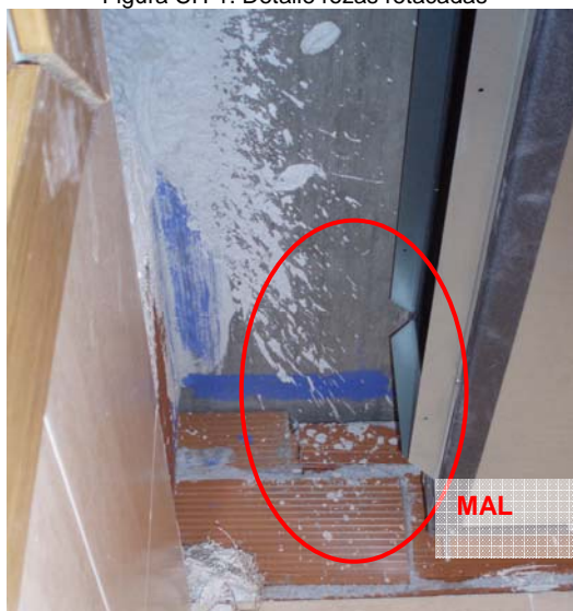
Figura CH-2. Detalle encuentro forjado partición
