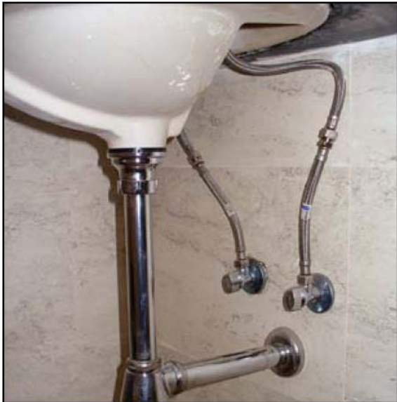
Figura CH-4. Conectores flexibles
