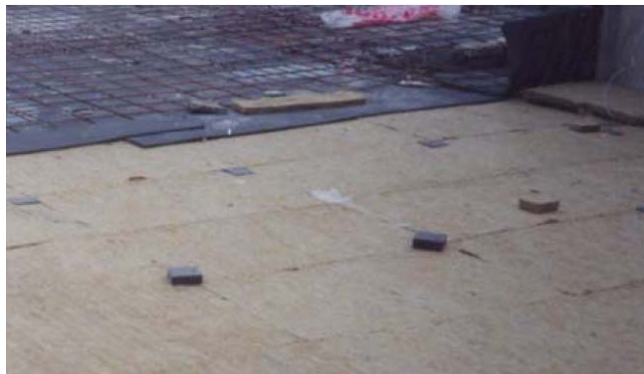
Figura R_INST-02. Ejemplo de un suelo flotante
