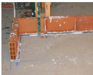
Detalle del replanteo y ejecución de particiones con bandas elásticas
